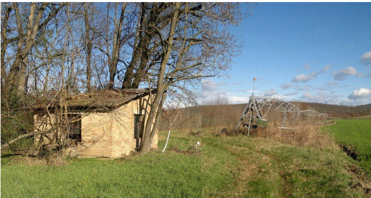
Panoramica del locale tecnico esistente sulla part. 80 e dell’ala pivot.
