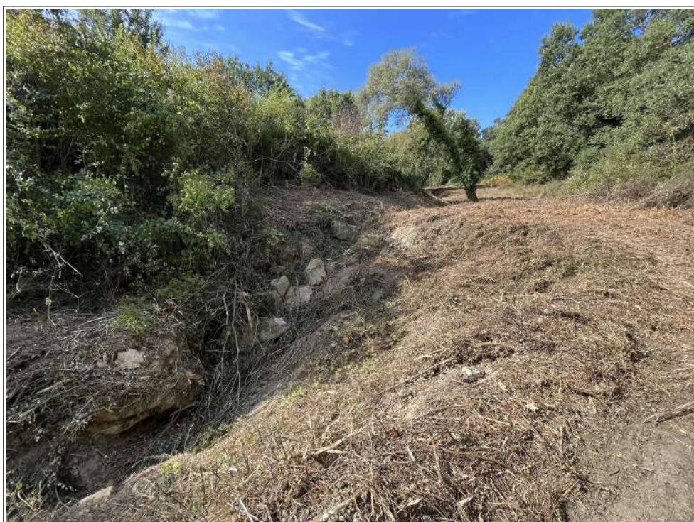
Figura 4 - Tratto del Fosso Cavernano interessato da erosione e smottamenti (vista da nord).
