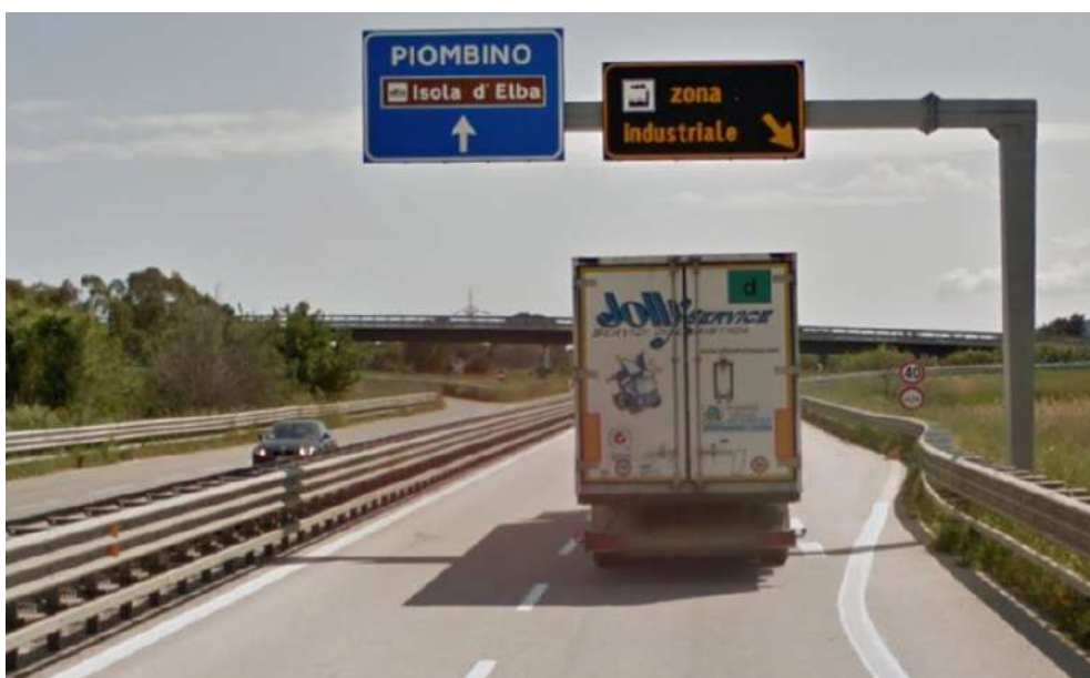
Figura 6: Strada statale SS n. 398 a due corsie per senso di marcia con svincoli separati in ingresso ed uscita tipo autostradale.
