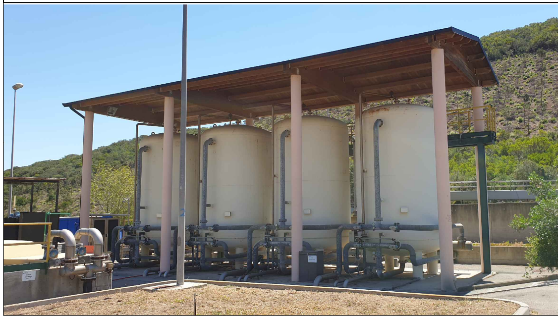
Filtrazione a carboni attivi (sezione attivabile ma non utilizzata)
