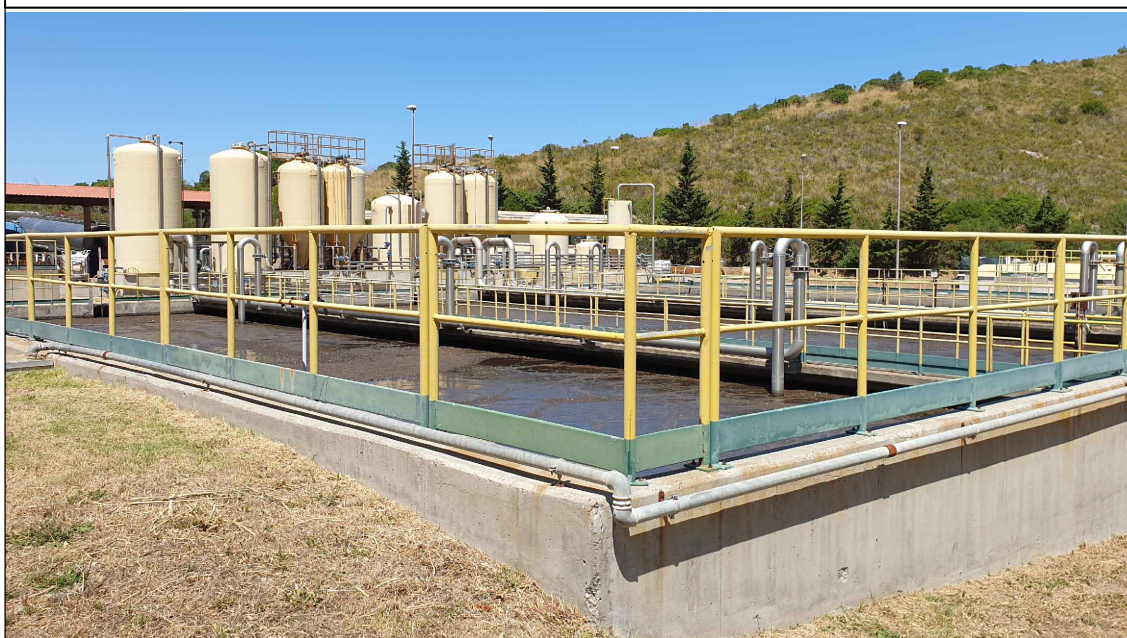
Vasca di reazione aerobica
