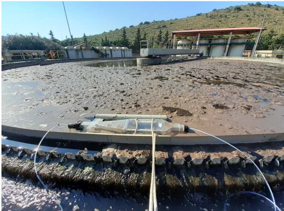
Figura 12: vasca di sedimentazione secondaria.
