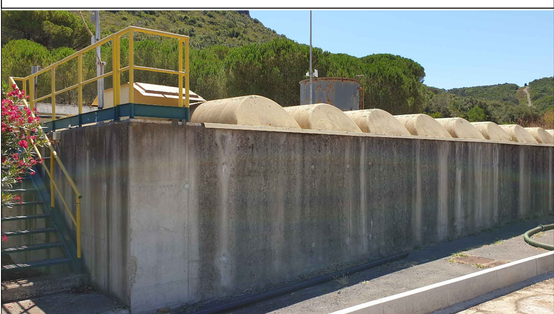
Vasca di stabilizzazione fanghi
