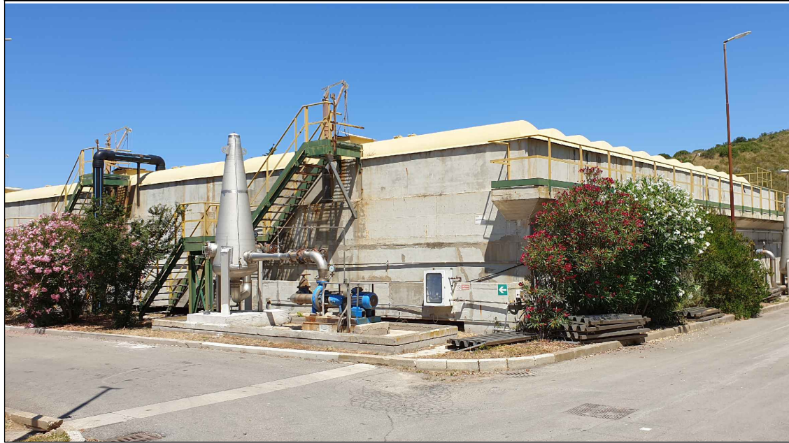
Vasca di accumulo acque di pioggia e vasche di equalizzazione
