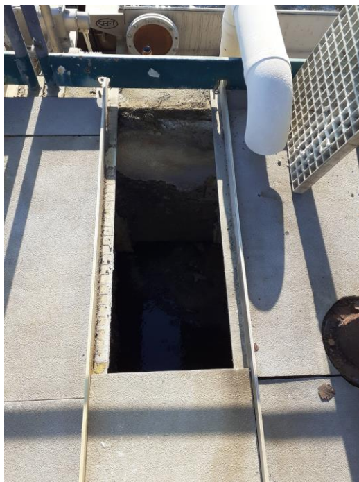
Figura 8: pozzetto arrivo liquami.
