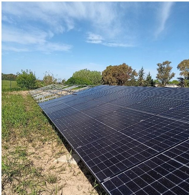
Figura 5.7 – Montaggio moduli su strutture di sostegno
