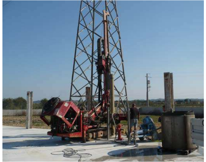
Foto 2 – Realizzazione piezometro Pz 2.
