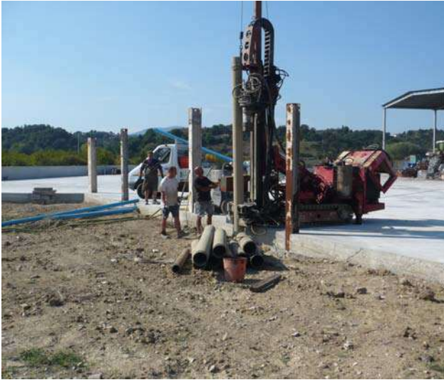
Foto 2 – Realizzazione piezometro Pz 2.
