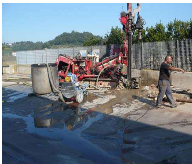
Foto 1 – Realizzazione piezometro Pz 1.
