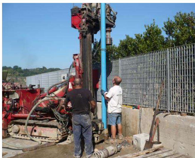
Foto 1 – Realizzazione piezometro Pz 1.
