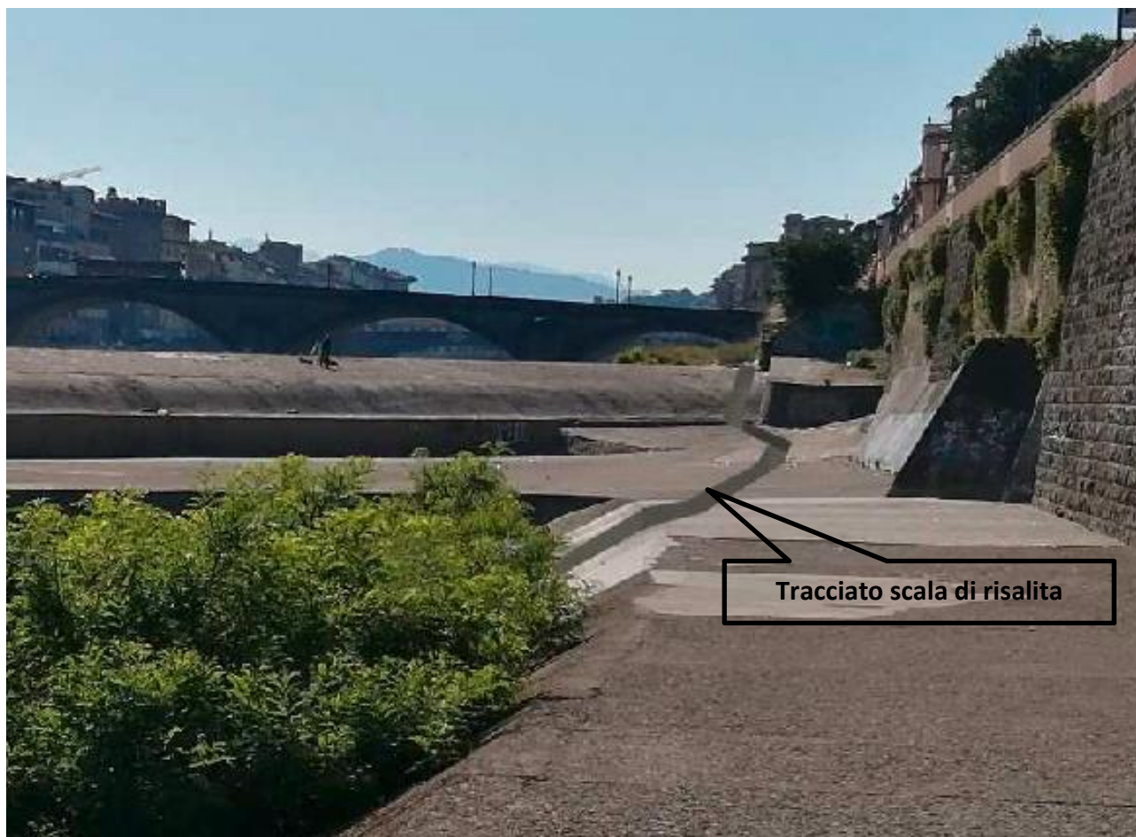
Figura 2: fotoinserimento di un possibile tracciato della scala di risalita dei pesci
