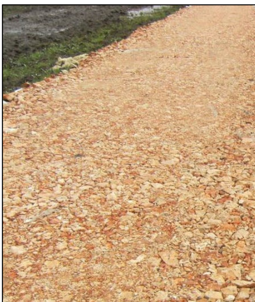
Figura 18 - Dettaglio costruzione viabilità interno con terreno stabilizzato
