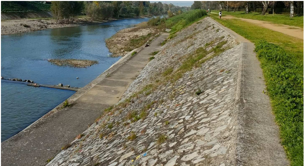
Figura 3: sponde esistenti rivestite in calcestruzzo e pietrame intasato
