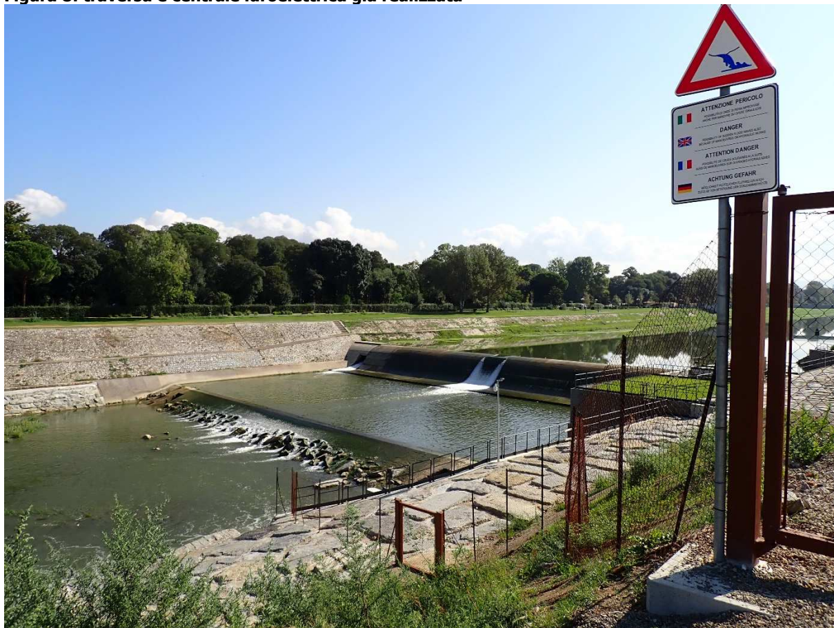
Figura 8: traversa e centrale idroelettrica già realizzata
