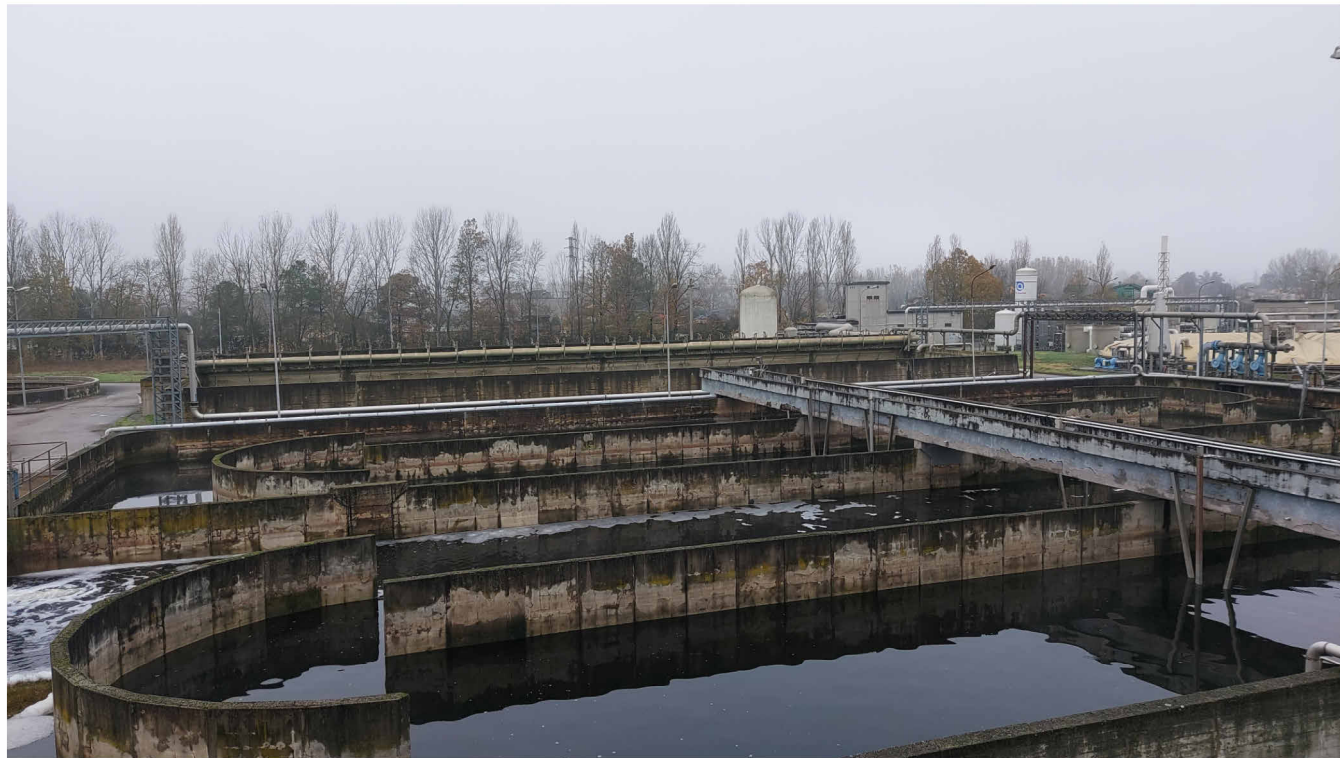
1 - Sezione di nitrificazione (utilizzata come accumulo acque piovane)
