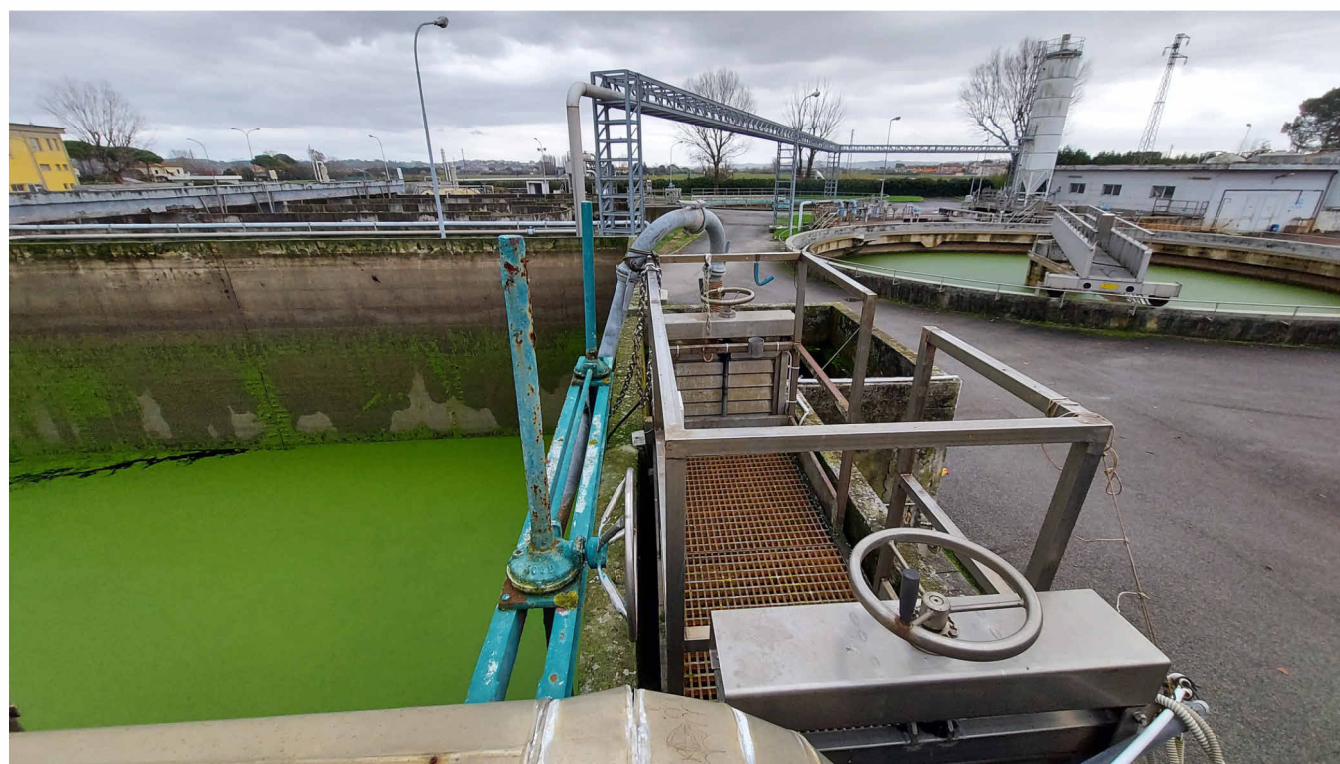
6 - Sezione di ossidazione e nitrificazione
