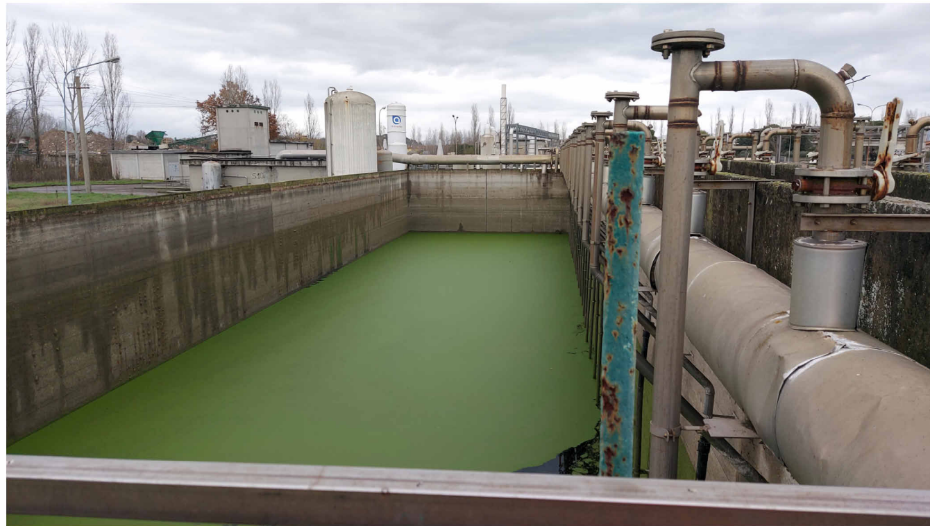
4 - Sezione di ossidazione e nitrificazione
