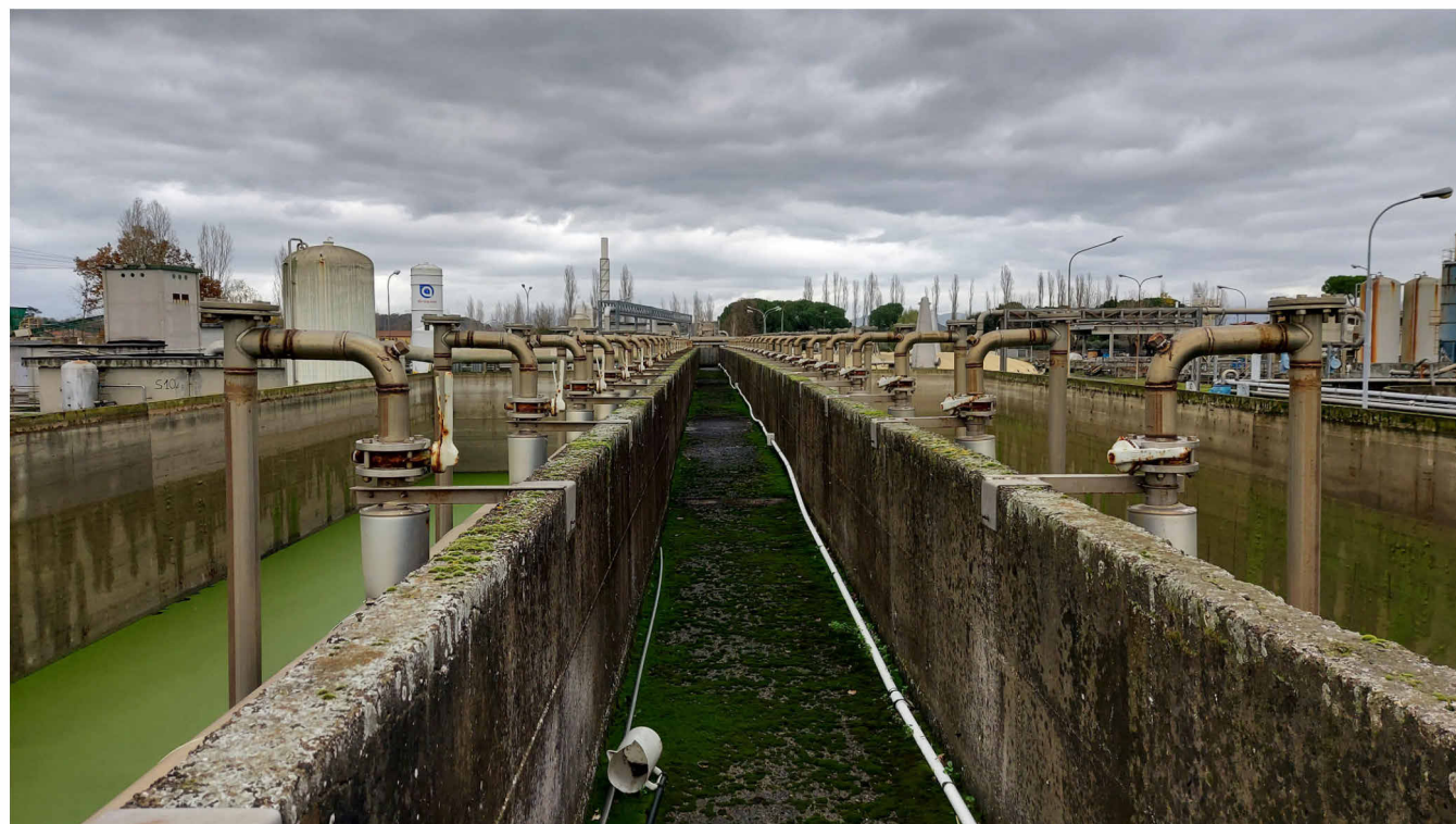
5 - Sezione di ossidazione e nitrificazione
