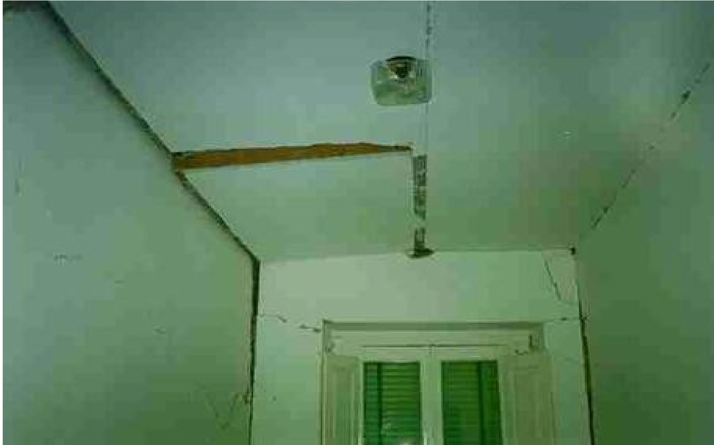
Dissesto del solaio per separazione dalle pareti e conseguente perdita di appoggio dei tavelloni.
