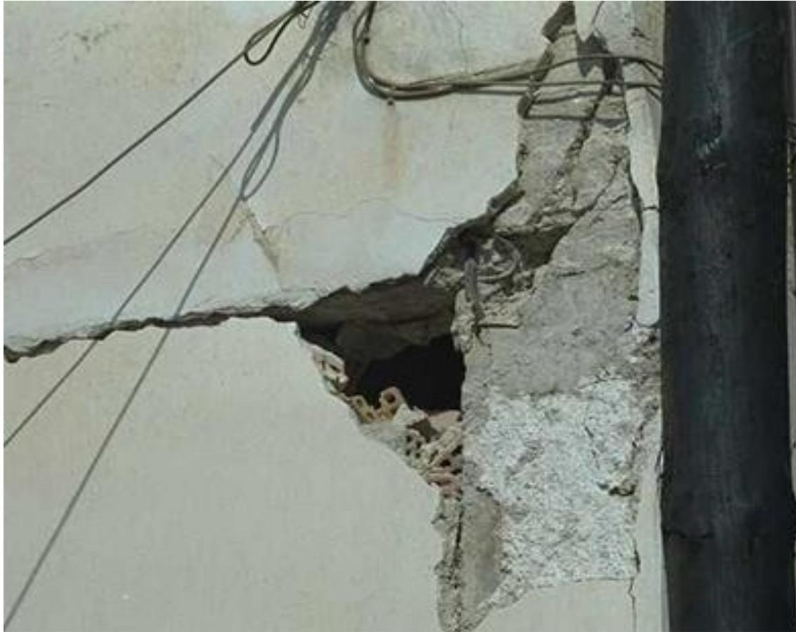
Danno al nodo e all'attacco del pilastro con espulsione del materiale fino al nucleo. (Atene, 1999)
