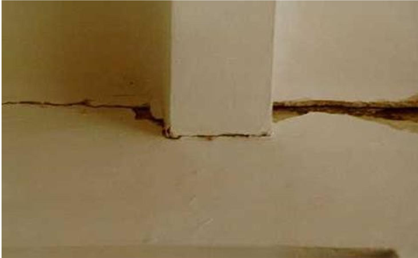
Vista dal basso del distacco fra solaio in legno e parete con inizio di sfilamento della trave. (Treia, 1998)
