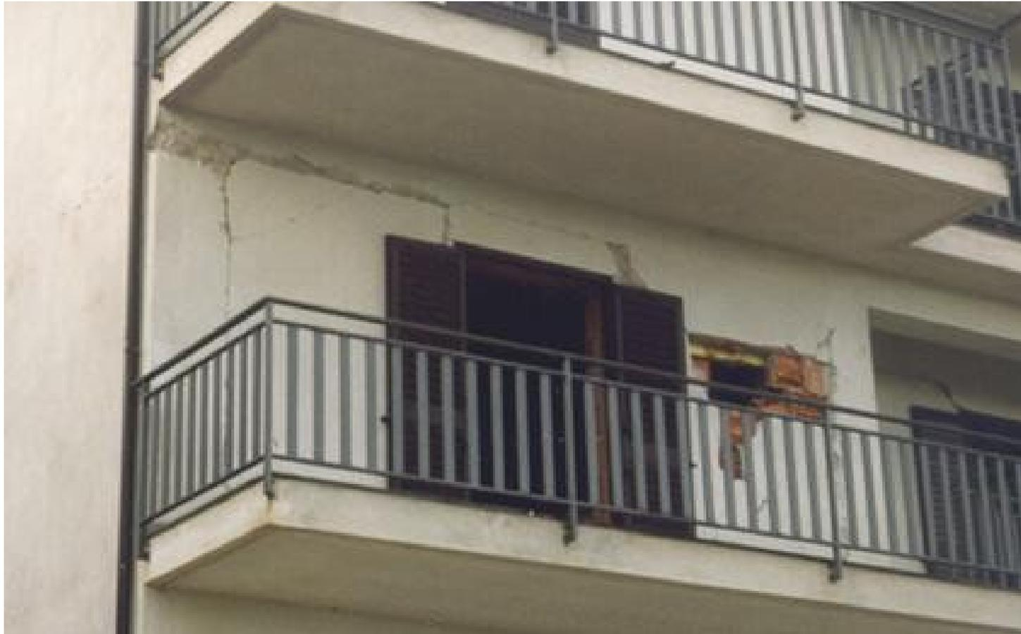
Lesioni orizzontali e verticali alla tamponatura, per distacco dalla struttura principale; crollo parziale della tamponatura fra le due porte.
