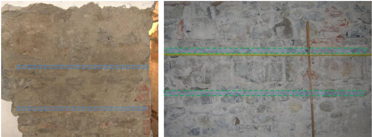
Figura 19: Esempi di muratura con presenza di orizzontamenti a distanza di circa 30-40 cm.
