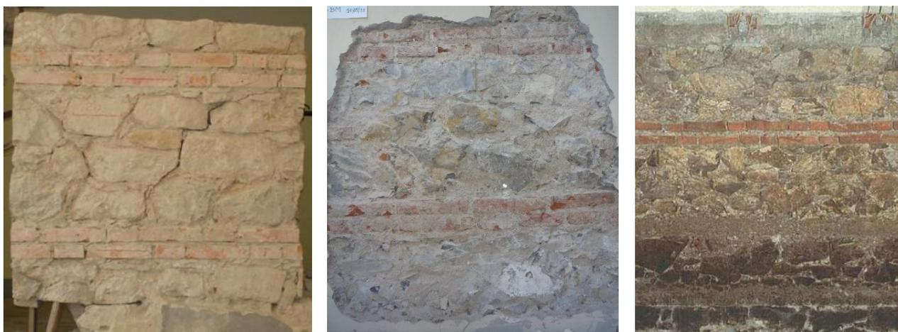
Figura 18: Esempi di murature con presenza di ricorsi in mattoni (a) e (b) e ricorsi in mattoni e cls (c).
