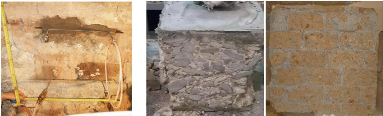
Figura 35: Esempi di "qualità/resistenza degli elementi" rispettata (a) e parzialmente rispettata (b) e (c).
