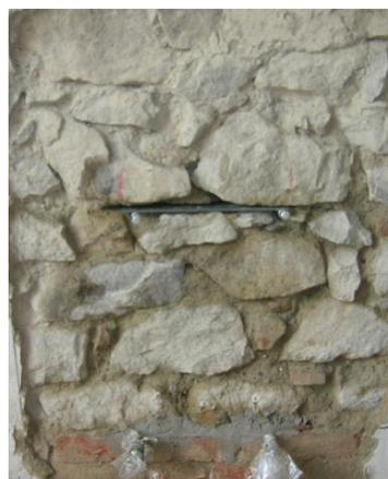
Figura 33: Esempi di “forma/regolarità degli elementi” non rispettata.
