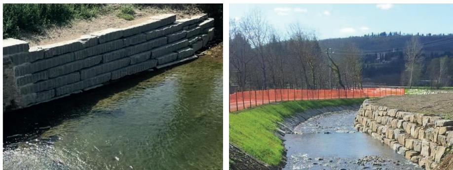
*Figura 15: Esempio di muro in scogliera*
