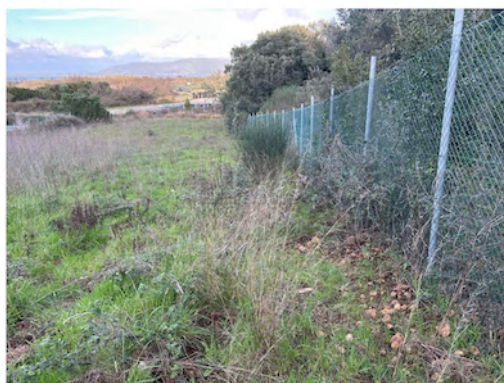
Foto 10. Stato attuale della porzioni perimetrali e del verde
