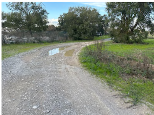
Foto 15. Strade interne esistenti
