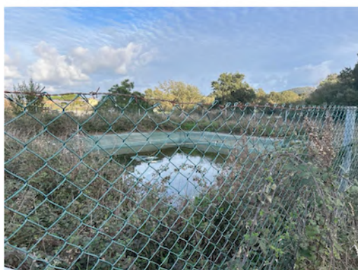
Foto 5. Stato attuale della vasca artificiale esistente
