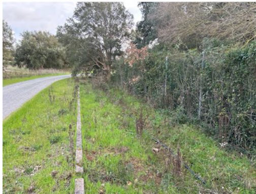
Foto 16. Strade interne esistenti con porzioni perimetrali
