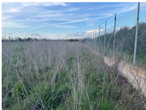
Foto 31. Stato attuale della porzioni perimetrali e del verde
