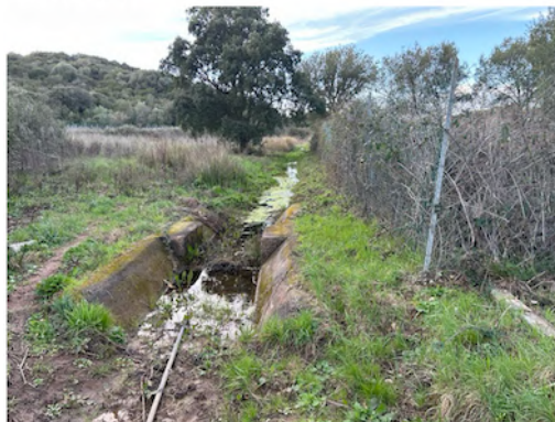
Foto 14. Porzione perimetrale con fossi di raccolta delle acque
