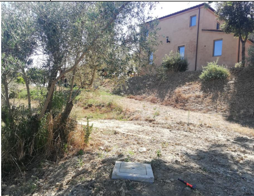
Pozzetto degrassatore – foto panoramica
