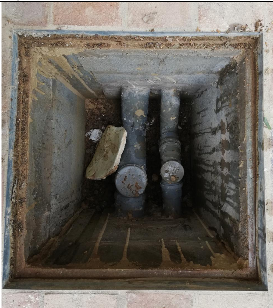
Foto Pozzetto di Ispezione 1
